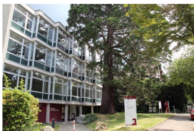
Campus I Karlstraße 63 79104 Freiburg
